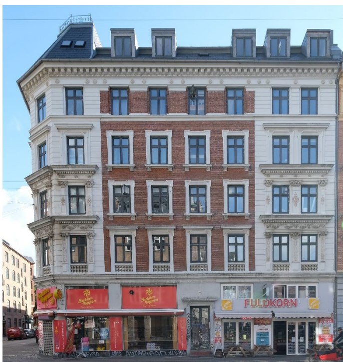
Eksempel på en bygning fra 1883 med en SAVE-værdi på 4, hvor der ikke kan etableres altaner på grund af de mange dekorationer på facaden.
