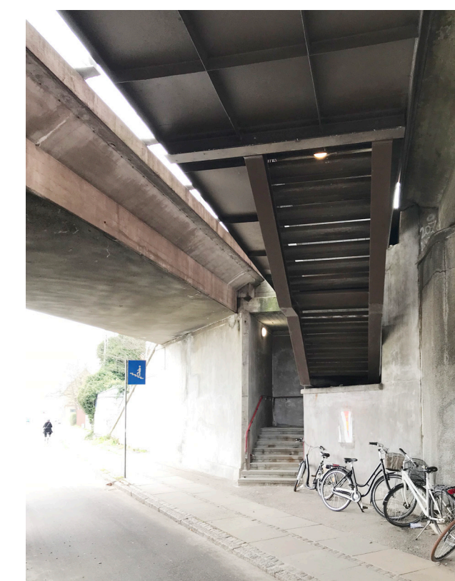
Nordlig trappeopgang fra Jyllingevej Station
