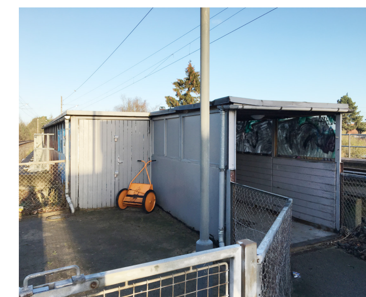
Indgang til gangbro fra Stationen
