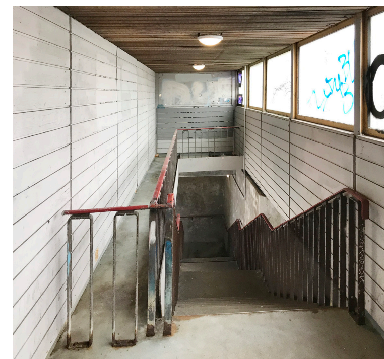
Nedgang til Jyllingevej
