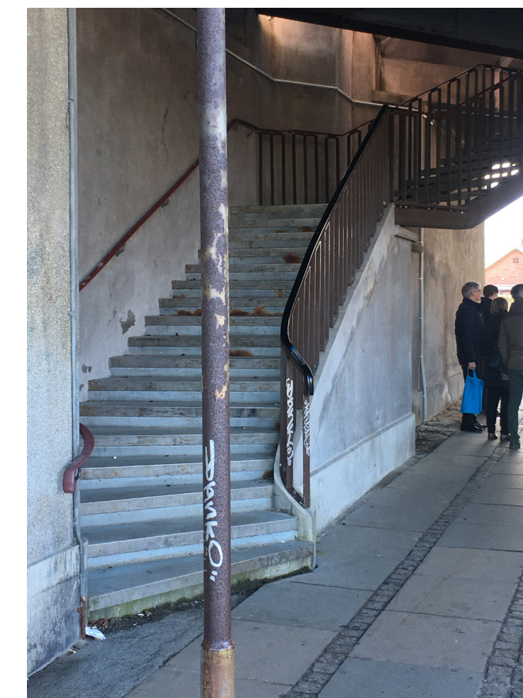
Sydlig trappeopgang fra Jyllingevej
